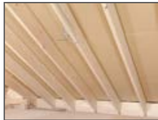
②通気層確保部材を施工する。
