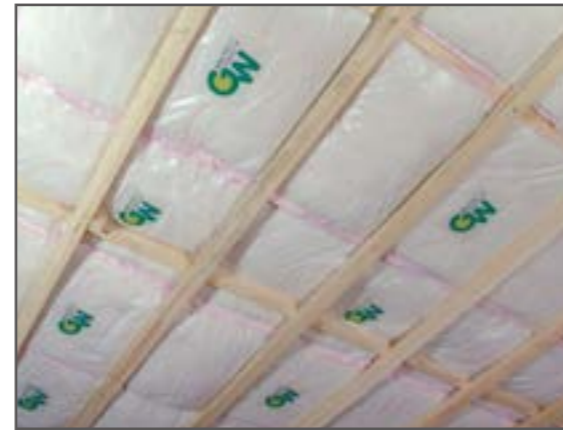
天井の施工例
