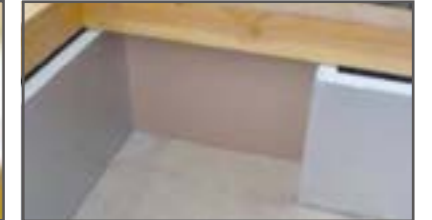
基礎断熱の断熱材と気密テープを使用し、人通口の断熱性と気密性を確保するためのふたを施工した例
