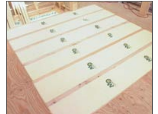
外気に接する床の施工例
