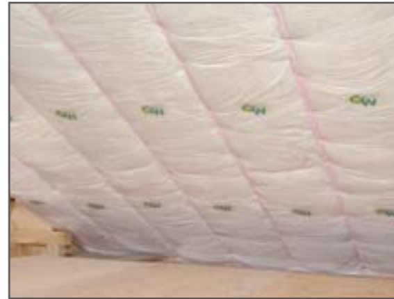
屋根の施工例
