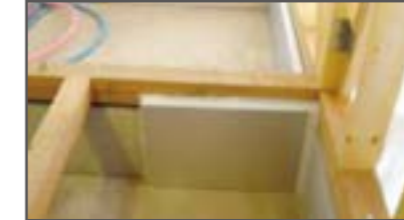
基礎断熱の断熱材と気密テープを使用し、人通口の断熱性と気密性を確保するためのふたを施工した例
