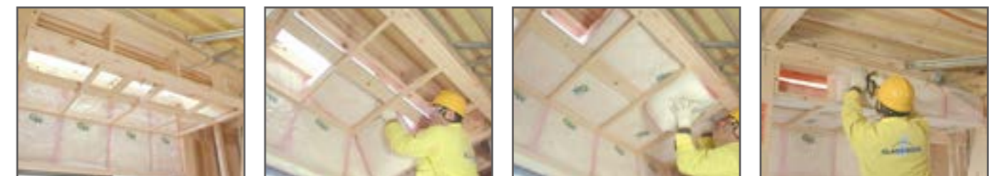
下屋の施工例（天井断熱の場合）
