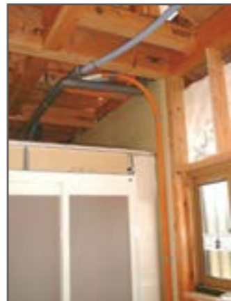
断熱・防湿施工が完了してからユニットバスを施工します。
