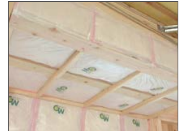
下屋の施工例（天井断熱の場合）
