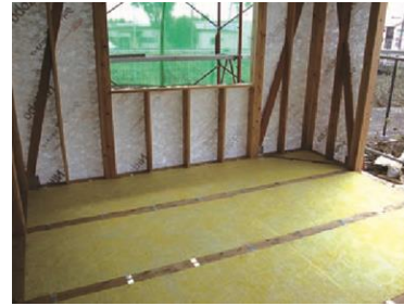
剛床(根太レス)の施工例
