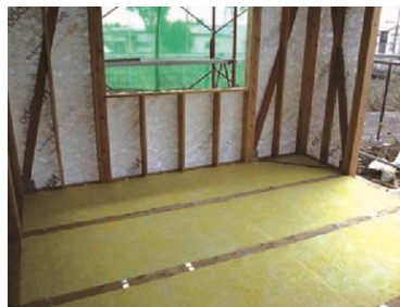
剛床(根太レス)の施工例
