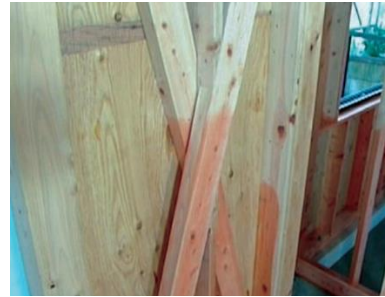
ダブル筋交い部の施工例
