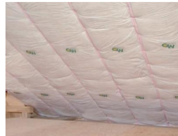
屋根の施工例
