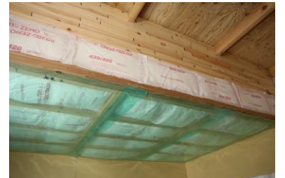
下屋の施工例(天井断熱の場合)
