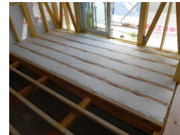
根太床の施工例
