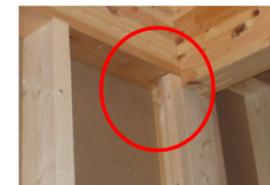
横胴縁や造作下地等の木下地裏など、断熱材を圧縮して充填した場合は、断熱材と木下地材が同面になるようにグラスウールに切れ目を入れ、盛り上げます。
