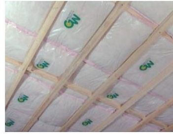
天井の施工例
