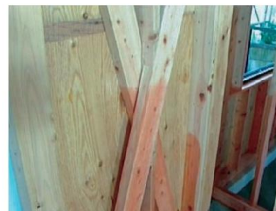
ダブル筋交い部の施工例
