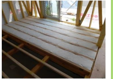
根太床の施工例
