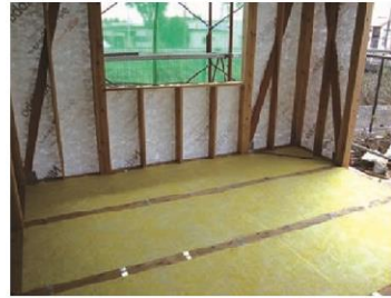
剛床（根太レス）の施工例
