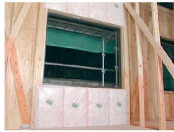
開口部周りの施工例
