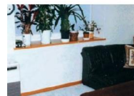
洋室の例：床と壁の取合い部に気流止めが施工されていない。
