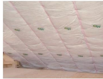
屋根の施工例
